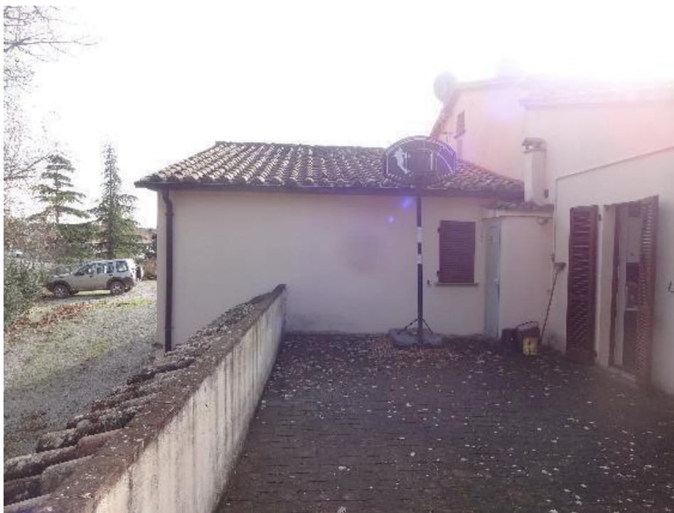
Fig.22: Stato di fatto prospetto est.(01/12/2023)
